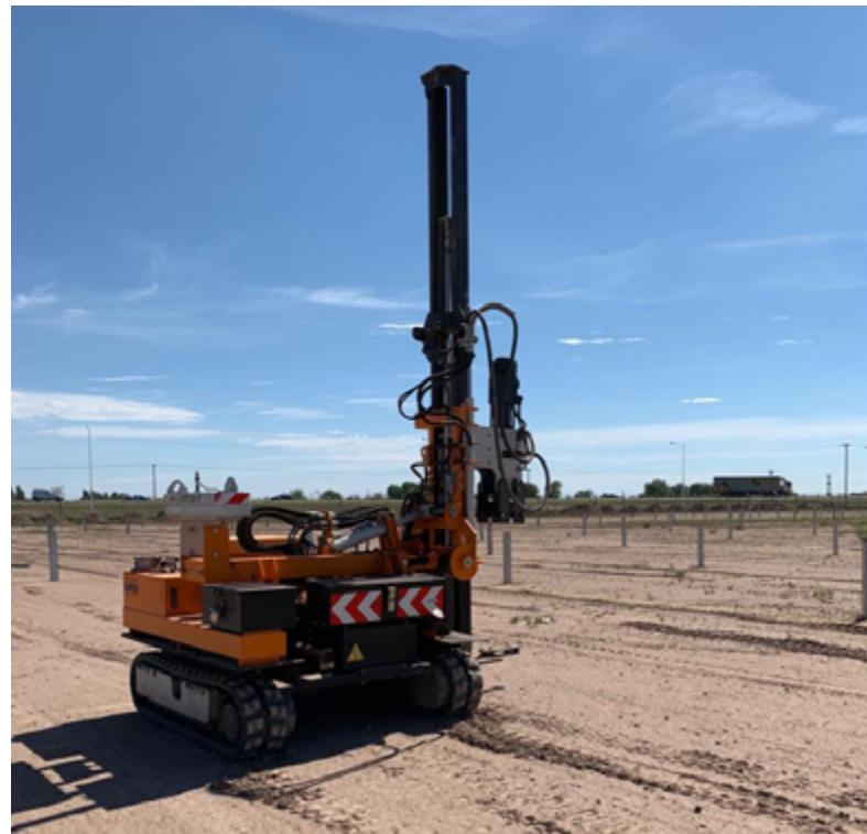
**Ensayos de penetración en el terreno y posterior hincado de postes para estructuras con seguidores solares (trackers)**
