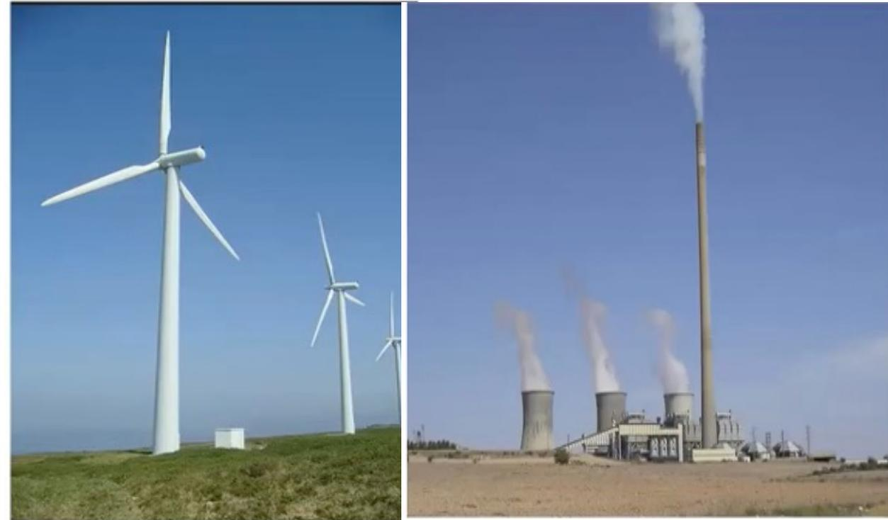
Por ejemplo, una potencia eléctrica de 1.000 MW (instalada con 200 aerogeneradores de 5 MW), necesita actualmente unas 160.000 toneladas de acero, 2.000 de cobre, 780 de aluminio, 110 de níquel, 85 de neodimio y 7 de disprosio. La misma potencia instalada con gas natural como combustible requiere unas 5.500 toneladas de acero, 750 toneladas de cobre y 750 de aluminio aproximadamente, es decir, **25 veces menos cantidad** de metales que en el caso de la eólica (Valero, et al. 2018)
